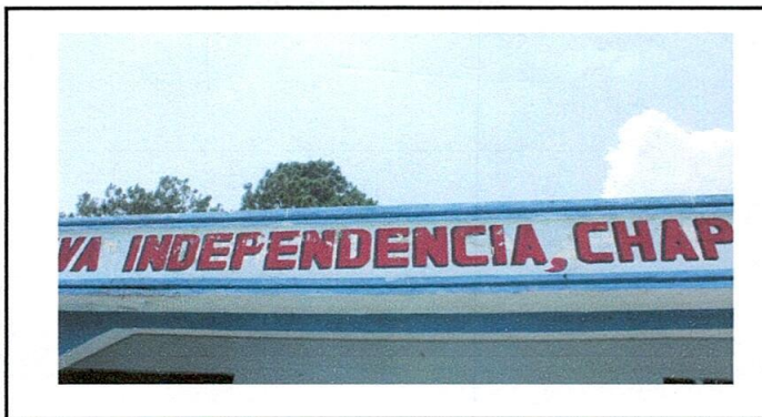
Foto 6: Alisado de muro de techo
