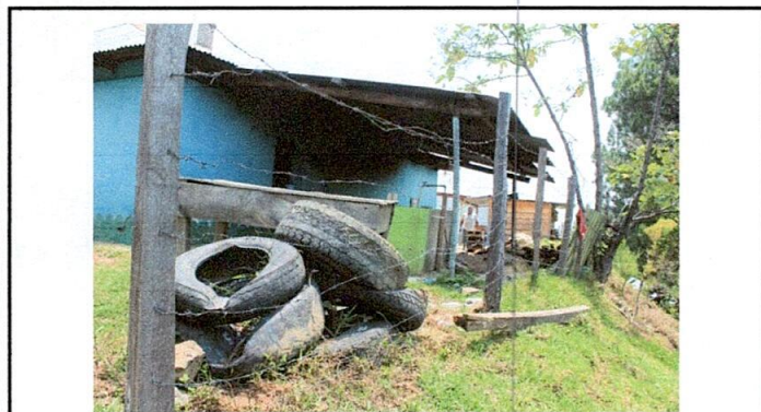
Foto 3: Sustitucion de cerco perimetral
