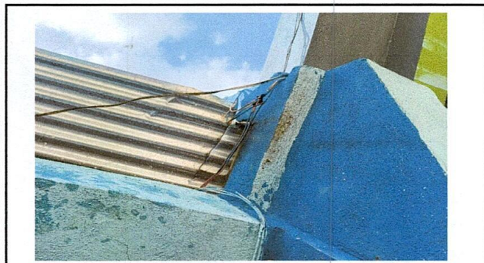
Foto 1: Sustitución de lamina
