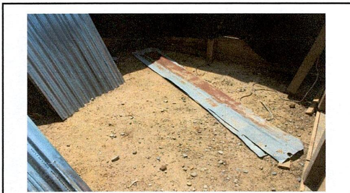
Foto 2: sustitucion de piso
