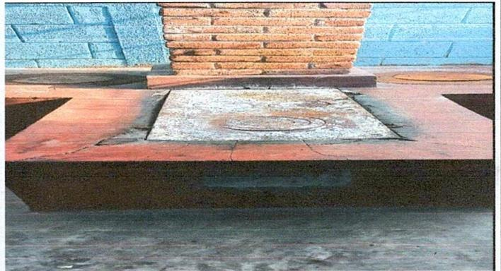
Foto 4: Sustitución de plancha de metal de 3 hornillas
