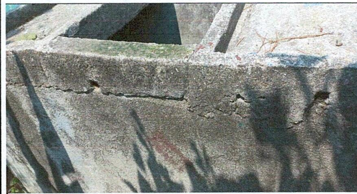
Foto 5: Sustitución de pila de cemento de dos lavaderos
