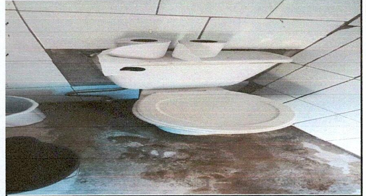
Foto 2: Sustitución de accesorios de inodoros
