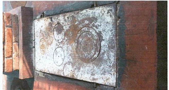
Foto 4: Sustitución de plancha de metal de 3 hornillas
