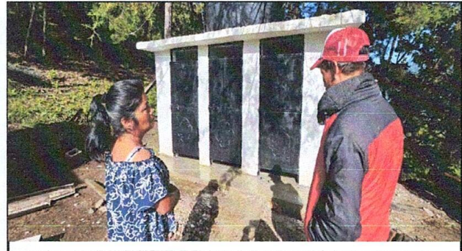
Foto 4: Terminación de sanitarios
