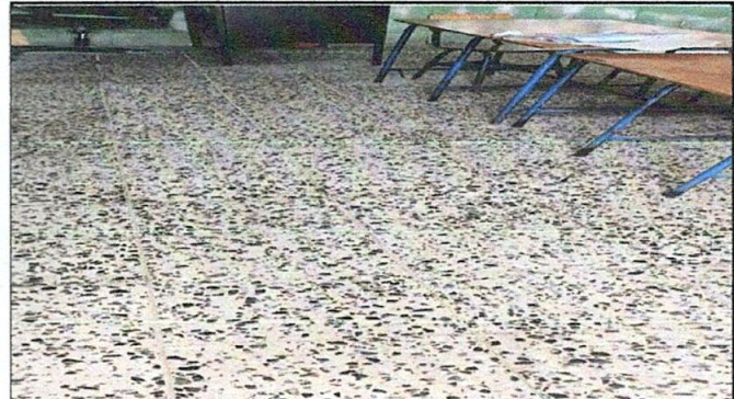
Foto 2: terminación de piso
