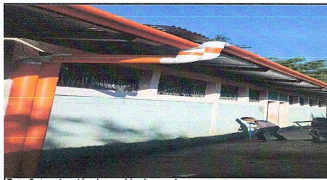
Foto 5: terminación de cambio de canales
