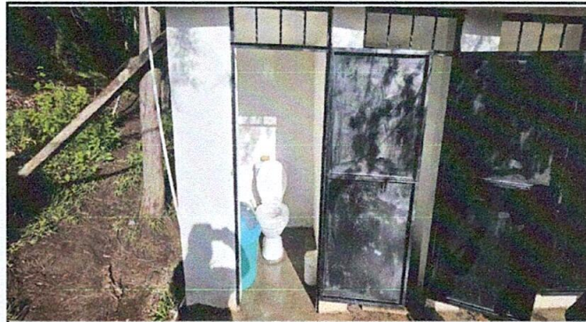
Foto 3: Terminación de sanitarios
