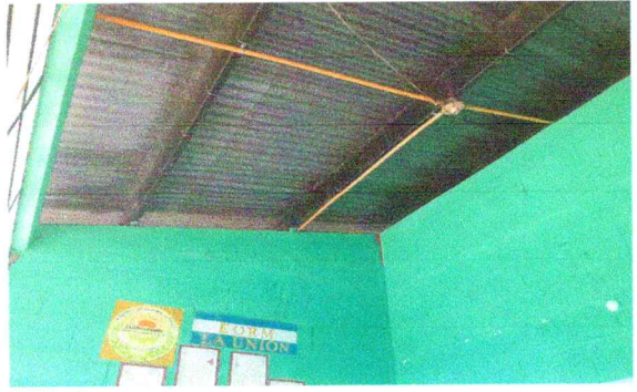
Foto 14: Sustrucción de plafoneras
