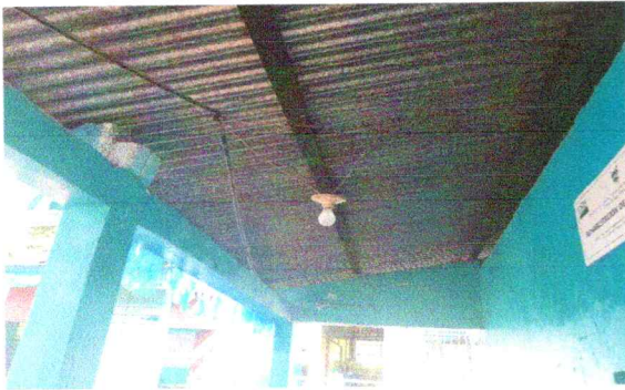
Foto 15: Reparación de cableado eléctrico
