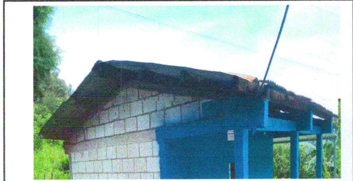
Foto 3: Sustitución de lámina en cocina escolar
