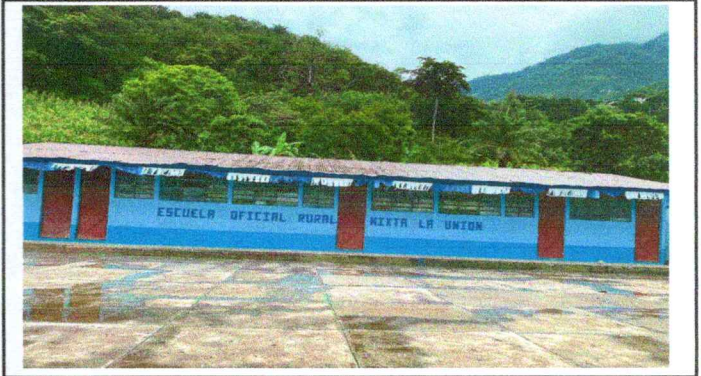
Foto 2: Sustitución de lámina en aulas
