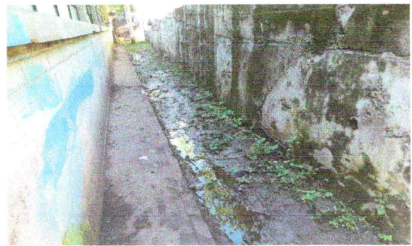
Foto 10: Reparación de cuneta de concreto
