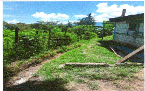
Foto 12: Reparación de cerco de pua
