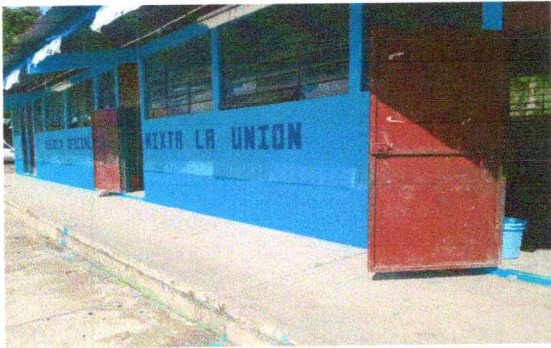
Foto 17: Aplicación de pintura a puertas
