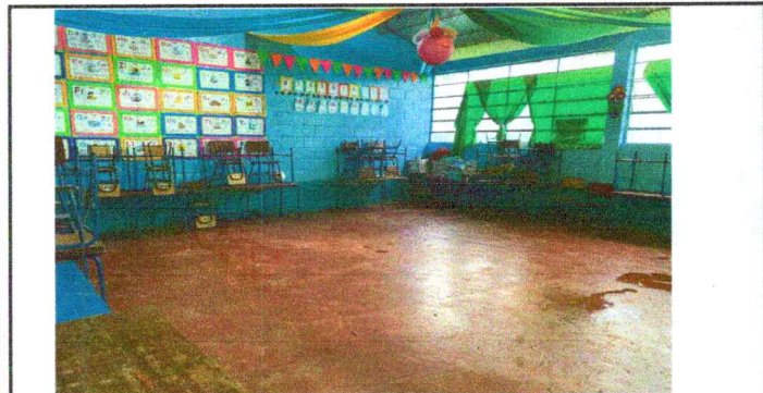
Foto 5: Sustitución de piso por piso de granito en aula
