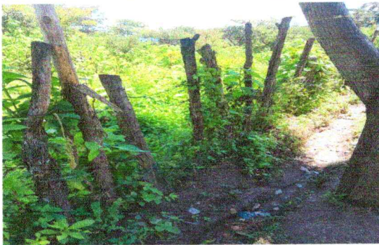
Foto 11: Reparación de cerco de pua
