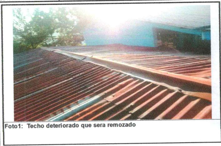
Foto 1: Techo deteriorado que sera remozado
