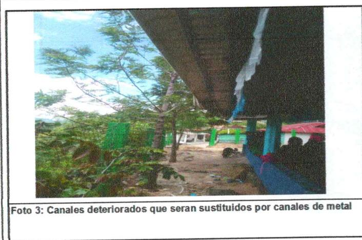
Foto 3: Canales deteriorados que seran susstituidos por canales de metal
