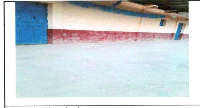
Foto 6: mejoramiento de valcones
