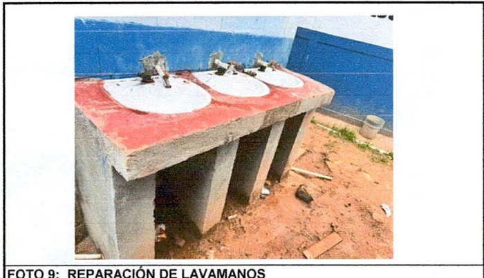
FOTO 9: REPARACIÓN DE LAVAMANOS
