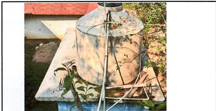
FOTO 11: SUSTITUCIÓN DE TINACO
