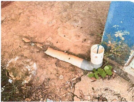
FOTO 3: SUSTITUCIÓN DE LÍNEA PLUVIAL
