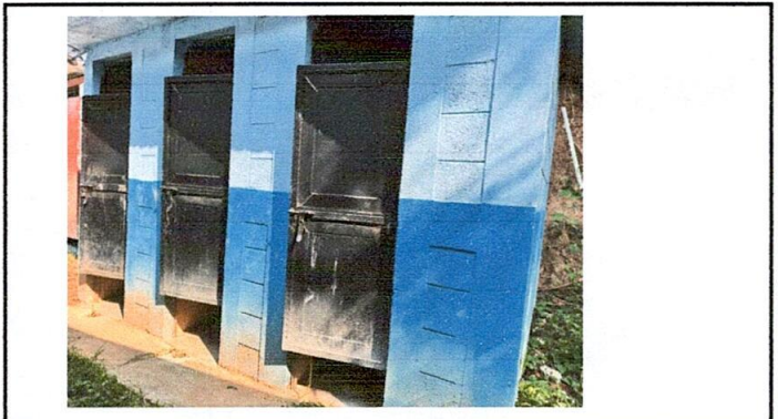
FOTO 10: PINTURA ANTICORROSIVO EN PUERTAS
