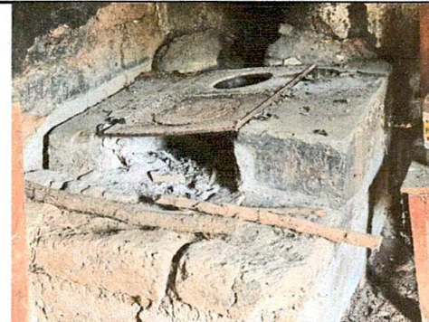
FOTO 6: SUSTITUCIÓN DE PLANCHA
