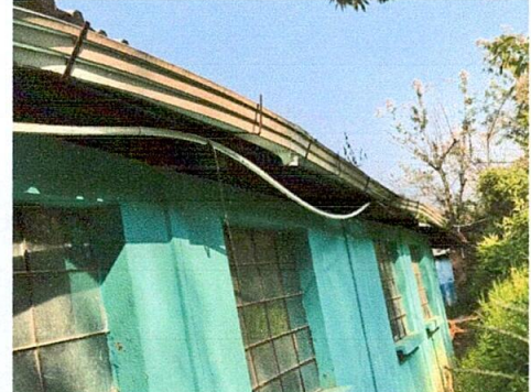
FOTO 2: SUSTITUCIÓN DE CANAL DE PVC
