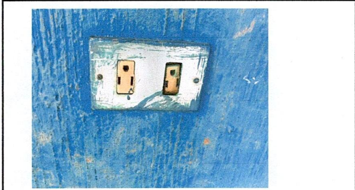
FOTO 7: REPARACIÓN DE TOMA CORRIENTE
