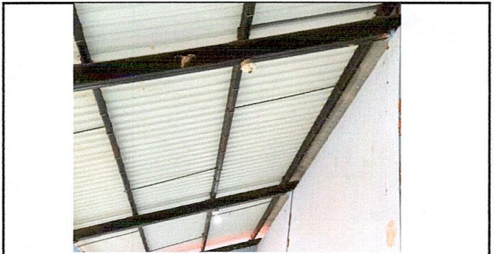
FOTO 12: REPARACIÓN DE CABLEADO ELÉCTRICO Y FOCOS
