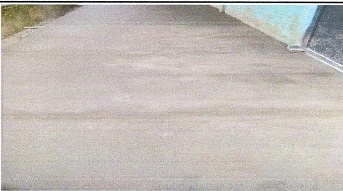
Foto 3: Sustitución de piso de concreto finalizado.
