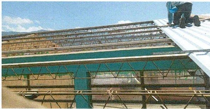
Foto 1: Lámina y capote en proceso.
