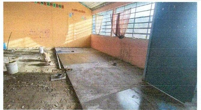
Foto 2: Piso de concreto en aulas en proceso.
