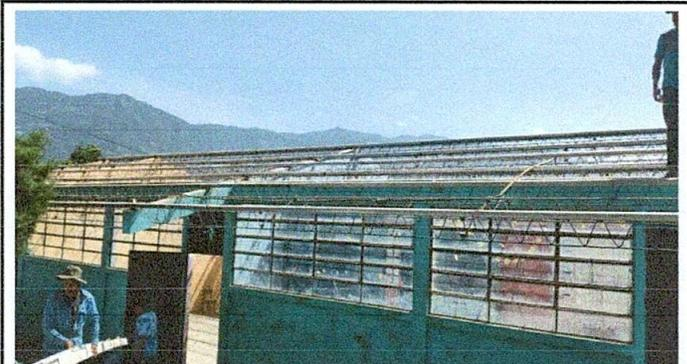
Foto 4: Sustitución de canales y bajadas de agua en proceso.
