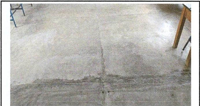
Foto 2: Piso de concreto en aulas en malas condiciones.
