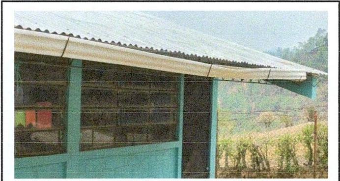
Foto 4: Sustitución de canales de bajadas de agua en malas condiciones.
