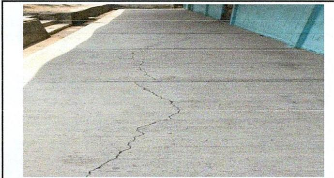
Foto 3: Sustitución de piso de concreto en malas condiciones.
