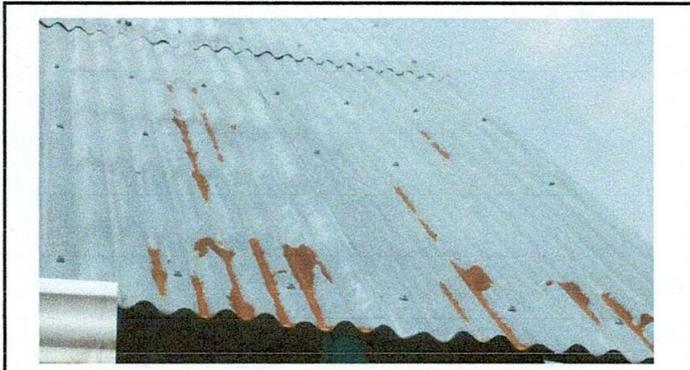
Foto 1: Lámina y capote en malas condiciones.
