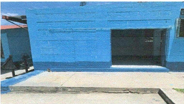
Foto 5: Aula en la parte exterior pintada.
