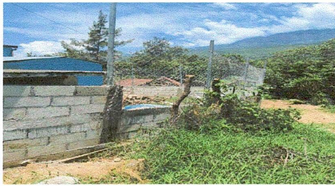
Foto 1: Lado Este circulación terminada.
