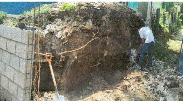
Foto 3: Lado Oeste preparación del terreno para la circulación.
