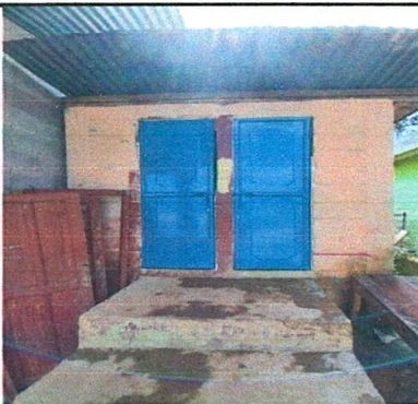
Foto 3: Sustitución de puerta en servicio sanitarios.
