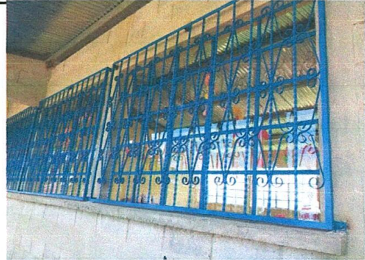
Foto 4: Vidrios para ventanas y valcones de la escuela.
