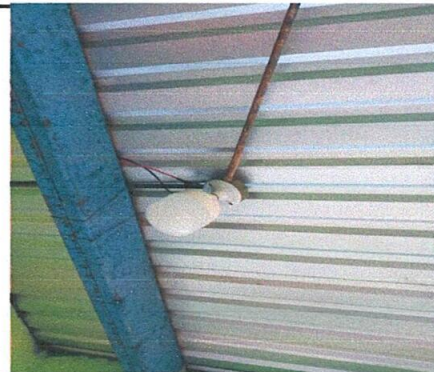
Foto 6: Reparación de sistema eléctrico.
