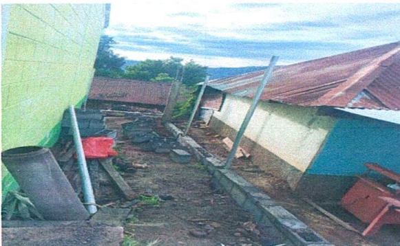
Foto 5: Reparación de muro perimetral de block con tubo hg y malla.
