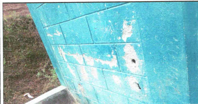
Foto 5: Repello en paredes de servicio sanitario
