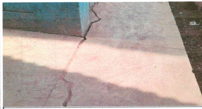
Foto 5: Sustitucion de piso de torta de cemento
