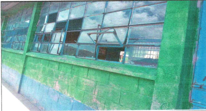
Foto 1: Pintura en paredes.
