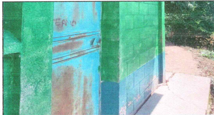
Foto 3: Mantenimiento a puerta de metal.
