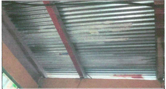
Foto 2: Estructura de soporte de madera.
