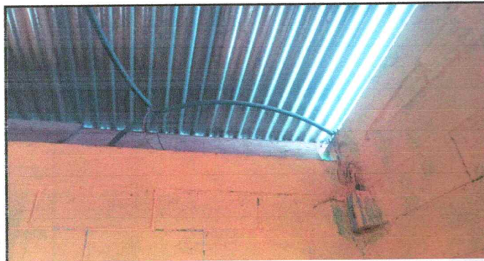
Foto 3: sustitucion de cableado eléctrico.
