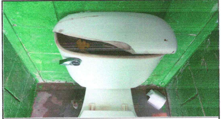
Foto 2: Sustitucion de accesorios en sanitarios
