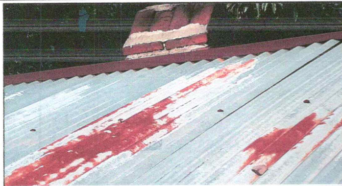
Foto 1: Cubierta de lámina
