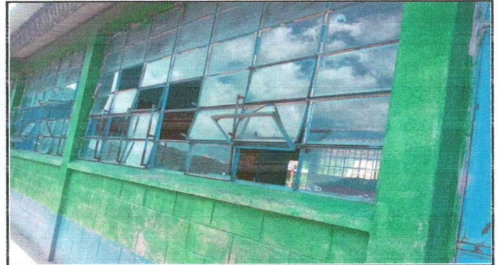
Foto 4: Sustitución de estructura de metal mas vidrio.
