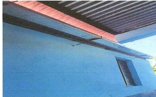
Foto 4: sustitución de canal de metal
