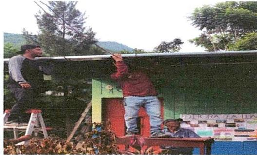
Foto 4: sustitución de canal de metal
