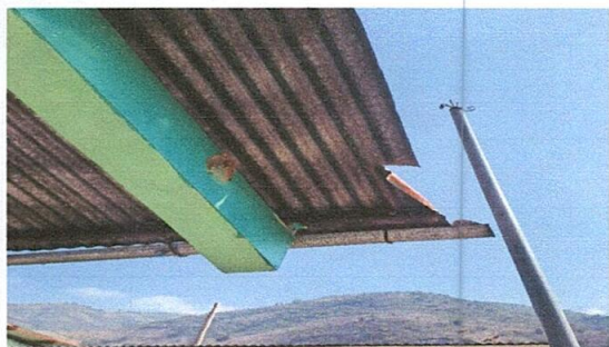
Foto 3: sustitución de lámina
