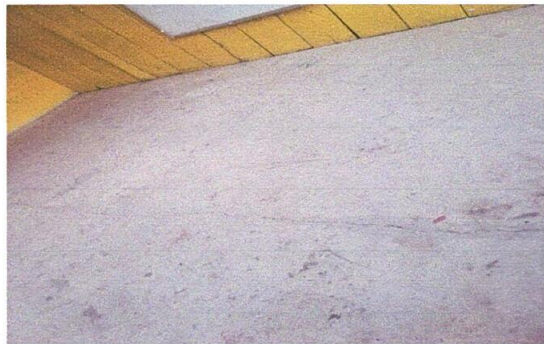
Foto 2: sustitución de piso de granito
