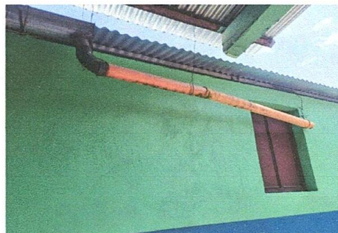
Foto 4: sustitución de canal de metal
