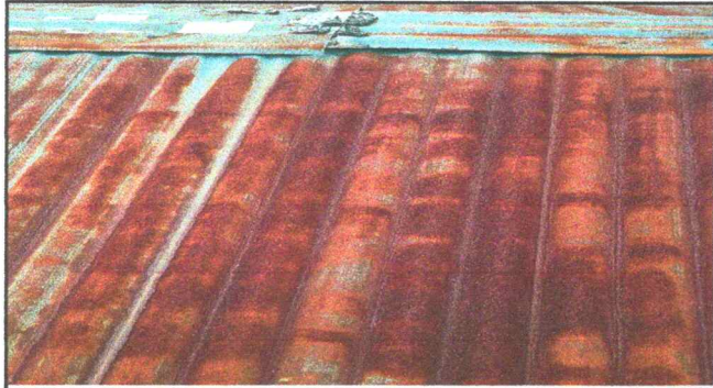
Foto1: Techo de la escuela
