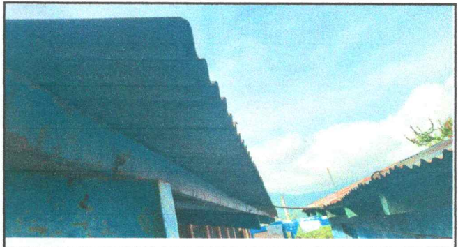
Foto 4: Bajada de agua
