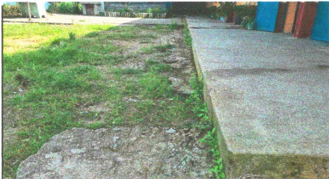
Foto 5: Cunetas de concreto
