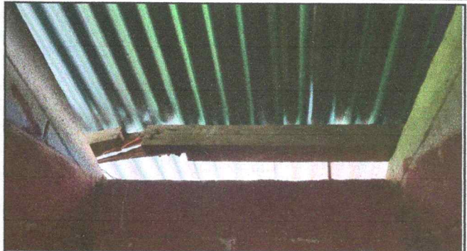
Foto 2: Soporte de madera del baño
