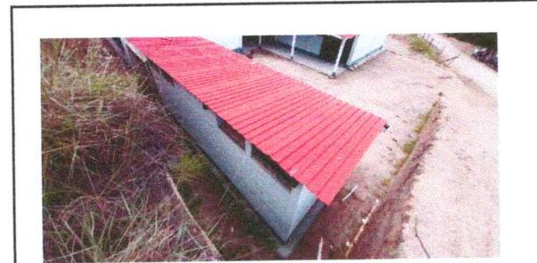
Foto 5: Cubierta de lámiana en mal estado y es utilizada para captación de agua de lluvias
