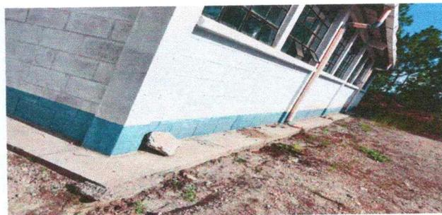
Foto 4: Banqueta de concreto dañado
