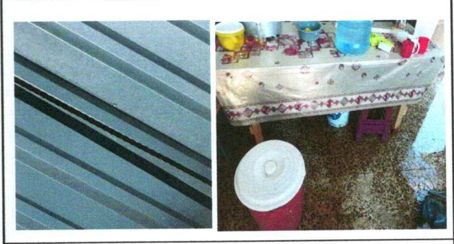
**Foto 2: Cubierta de lámina en mal estado entra agua**
