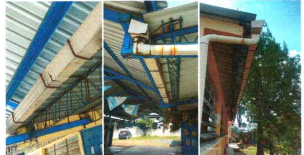
Foto 2: Canales detereorados
