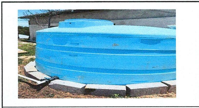
Foto 5: Depósito de agua nuevo e instalado
