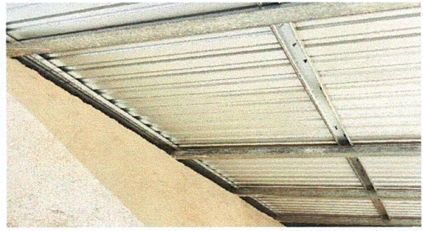
Foto 8: Solera de terminación culminada con ensamble de estructura de soporte
