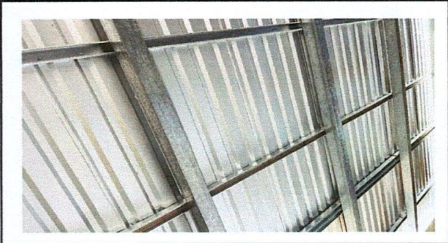
Foto 2: Estructura de soporte nueva e instalada
