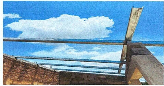
Foto: Armandó estructura
