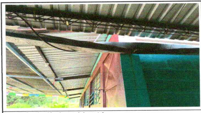
Foto 4: Sustitución de canal de metal
