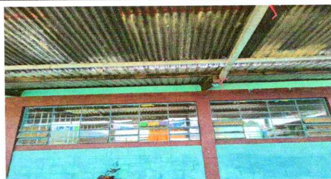
Foto 8: Mejoramiento de bajadas de agua pluvial
