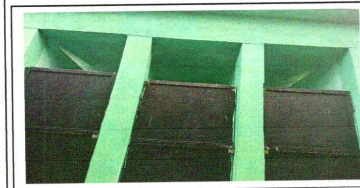
Foto 5: Mantenimiento de puertas y sustitución de caja de registro
