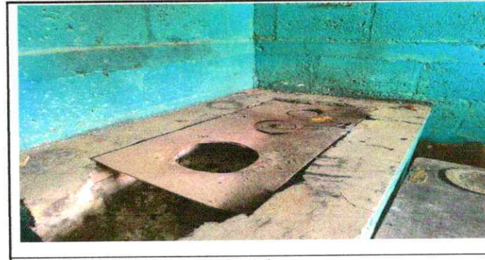
Foto 6: Sustitución de plancha de metal
