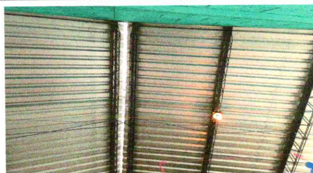
Foto 10: Reparación de sistema eléctrico
