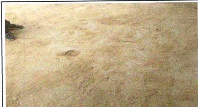
Foto 7: Sustitución de piso de torta de concreto
