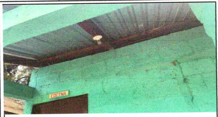
Foto1: Cubierta de lámina y estructura de techo
