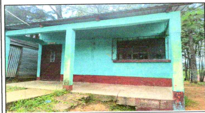
Foto 3: Sustitución de torta concreto por piso granito
