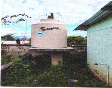
Foto 7: Abastecimiento de agua deficiente
