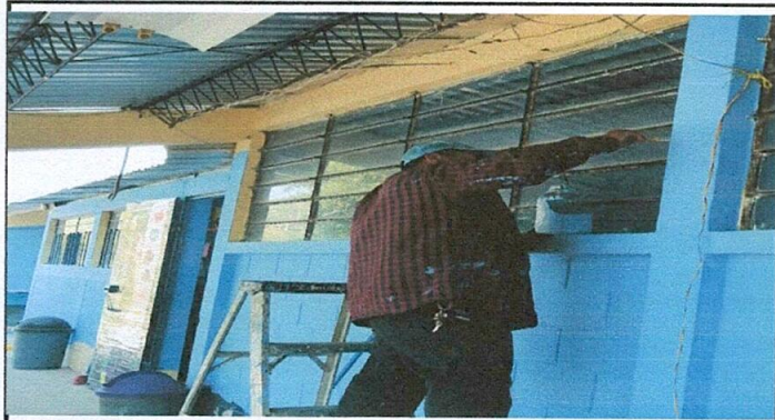
Foto 3: Sustitucion de ventanas y vidrios
