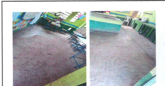
Foto 3: Piso líquido deteriorado y agrietado
