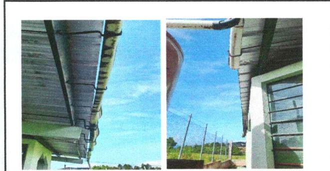
Foto 4: Canales de PVC en mal estado se deterioran rápido
