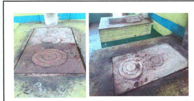
Foto 6: Estufa rural y plancha de cocina en mal estado
