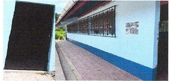
Foto 2: Puertas, Ventanas mantenimiento completo y las nuevas instaladas
