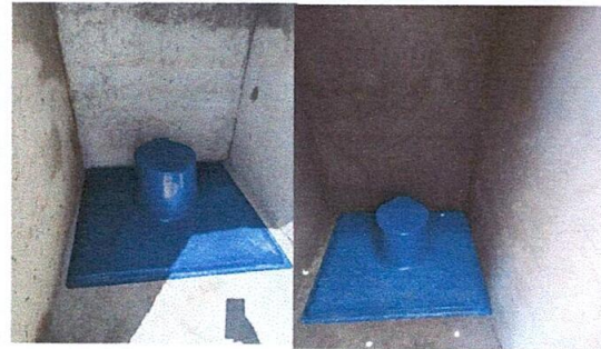
Foto 4: Sanitarios nuevos e instalados y terminados
