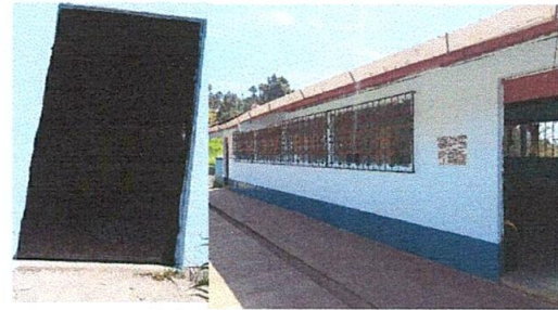
Foto 2: Puertas, ventanas dando mantenimiento e instalando nuevas
