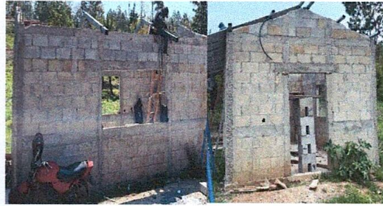
Foto 8: Proceso de mejoramiento pared cocina
