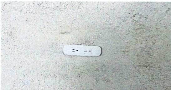
Foto 5: Sistema eléctrico en proceso de instalación
