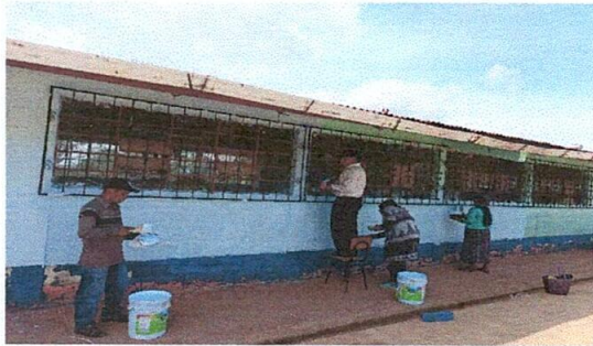
Foto 3: Proceso de aplicación de pintura
