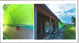
Foto 4: Pintura detereorada y aulas sin pintura
