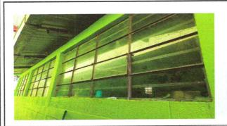
Foto 3: Ventanas y vidrios en mal estado
