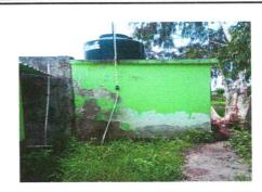
Foto 2: Paredes de baños detereoradas por humeda de adentro hacia afuera
