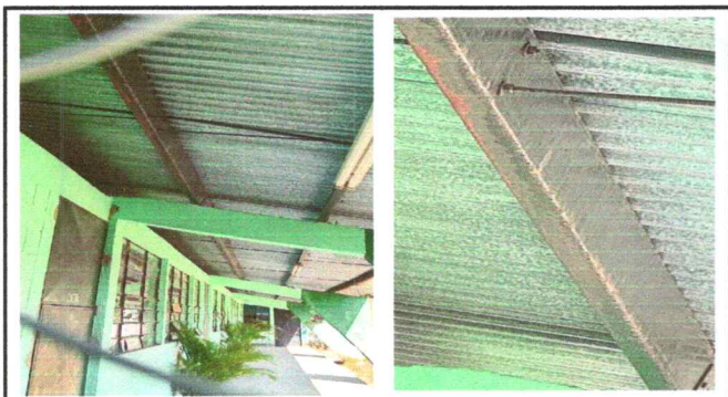
Foto 3: Estructura de soporte se encuentra en malas condiciones
