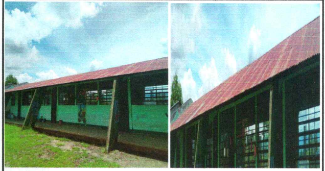
Foto 2: Las láminas del techo se encuentran deterioradas, necesitan mantenimiento
