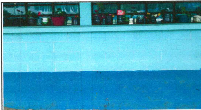
Foto 9: PINTURA EN MUROS EXTERIORES E INTERIORES
