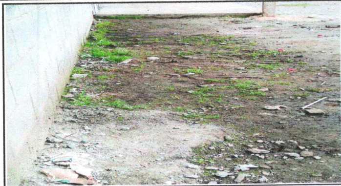
Foto 7: BANQUETA DE CONCRETO (MEJORAMIENTO DE BANQUETA DE CONCRETO)
