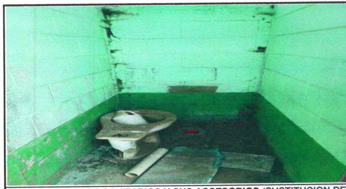
Foto 11: SERVICIOS SANITARIOS Y SUS ACCESORIOS (SUSTITUCION DE INODORO)
