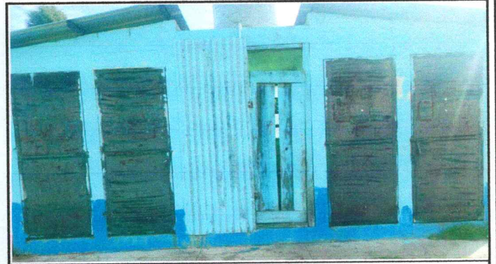
Foto 10: SERVICIOS SANITARIOS (MANTENIMIENTO A ESTRUCTURA (LIJADO Y APLICACIÓN DE PINTURA) A PUERTAS DE SERVICIOS SANITARIOS)
