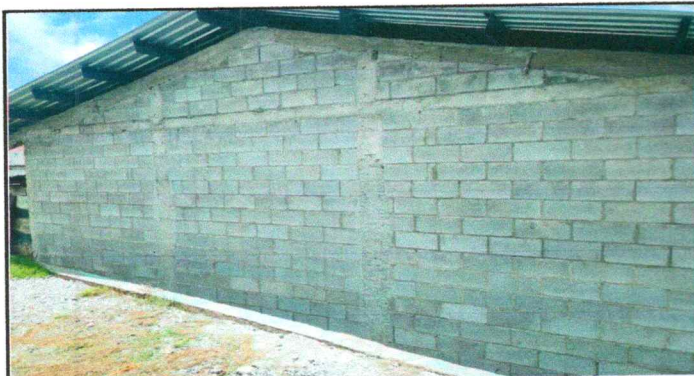
Foto 15: REPARACION DE REPELLO Y CERNIDO DE PAREDES
