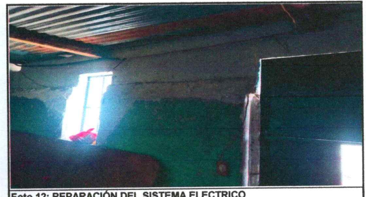
Foto 12: REPARACIÓN DEL SISTEMA ELÉCTRICO
