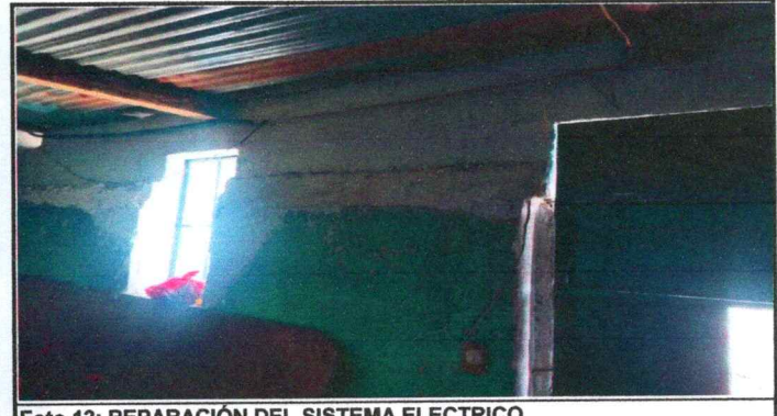
Foto 12: REPARACIÓN DEL SISTEMA ELECTRICO
