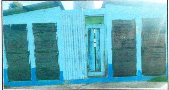
Foto 10: SERVICIOS SANITARIOS (MANTENIMIENTO A ESTRUCTURA (LIJADO Y APLICACIÓN DE PINTURA) A PUERTAS DE SERVICIOS SANITARIOS)
