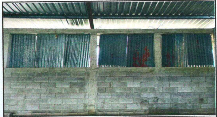
Foto 16: REPARACION DE REPELLO Y CERNIDO DE PAREDES
