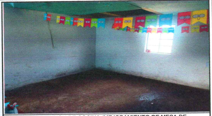
Foto 14: REPARACION DE COCINA (MEJORAMIENTO DE MESA DE CONCRETO)
