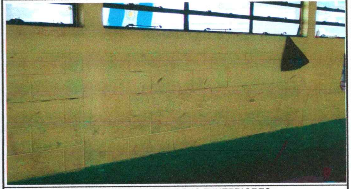
Foto 8: PINTURA EN MUROS EXTERIORES E INTERIORES
