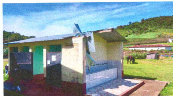
FOTO 5: SUSTITUCION DE TECHO Y ESTRUCTURA
