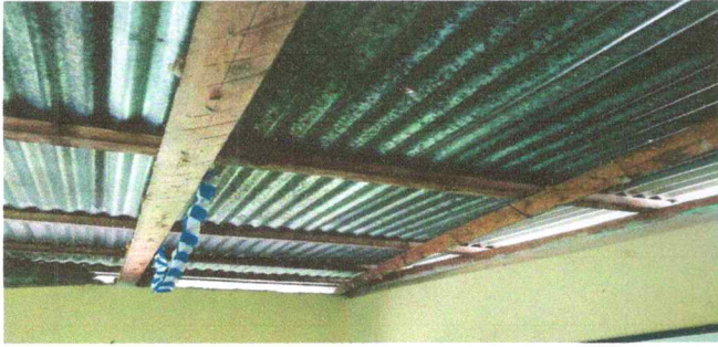
FOTO 1: SUSTITUCION DE ESTRUCTURA DE MADERA POR METAL
