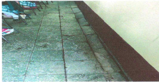
FOTO 5 : SUSTITUCION DE PISO GRANITO
