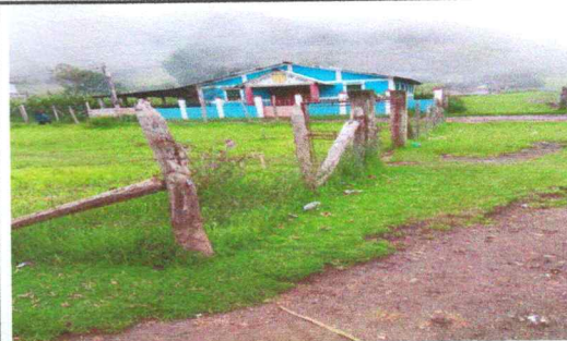
FOTO 2 : SUSTITUCION DE CIRCULACION
