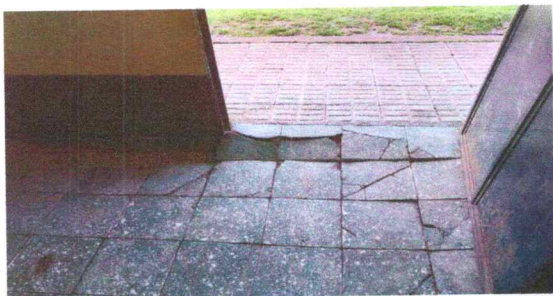
FOTO 1: SUSTITUCION DE PISO GRANITO
