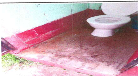
FOTO 5: SUSTITUCION DE INODOROS
