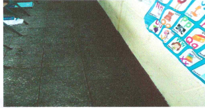
FOTO 6: SUSTITUCION DE PISO GRANITO
