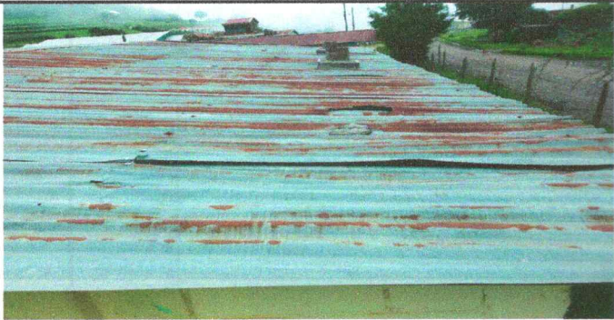
FOTO 3: SUSTITUCION DE LAMINA POR LAMINA TROQUELADA
