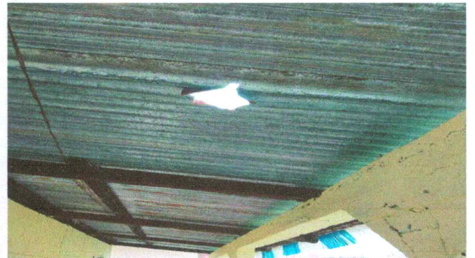
FOTO 4: SUSTITUCION DE LAMINA POR LAMINA TROQUELADA
