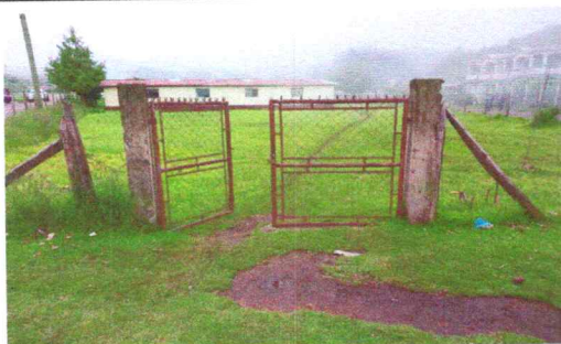
FOTO 3: SUSTITUCION DE PORTON
