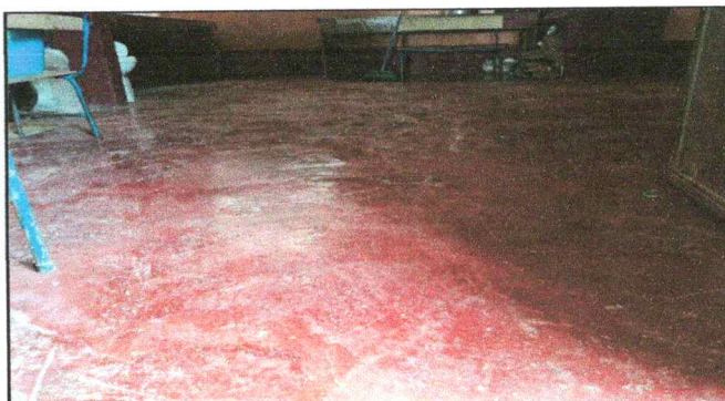
Foto 4: Reparación de piso granito, en el area de cocina
