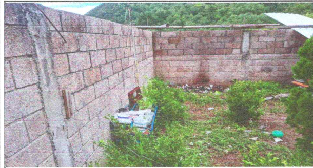
Foto 7: Sustritucion de lamina troquelada aluzinc
