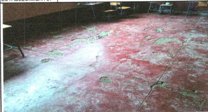
Foto1: Sustitución de piso Granito en aulas
