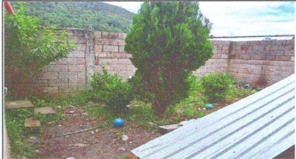
Foto 8: Mantenimiento a estructura de metal
