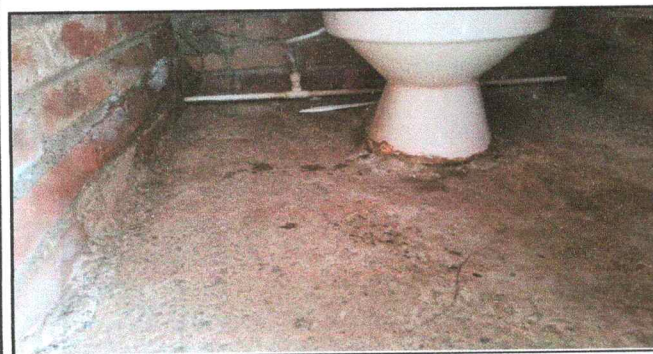
Foto 5: Sustitución de azulejo en baños
