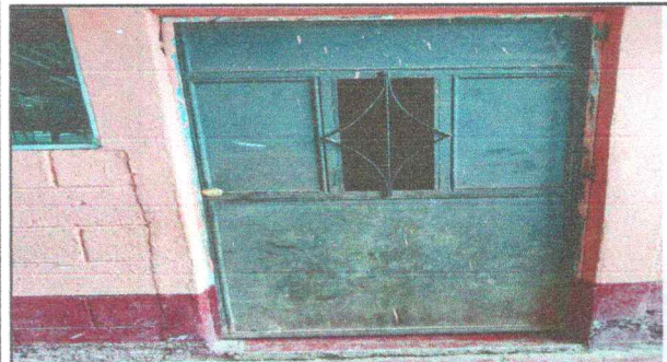
Foto 9: Mantenimiento a estructura de puerta
