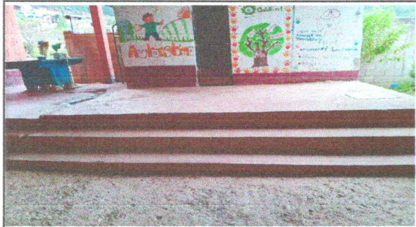
Foto 13: Reparación de piso del escenario
