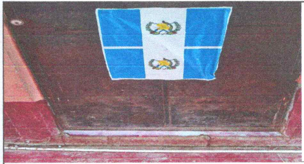
Foto 12: Sustritucion de puerta de metal para aula
