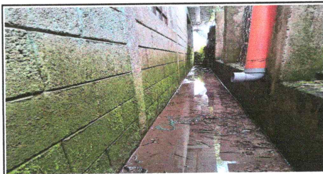
Foto 3: Reparación de cuneta de concreto, repello de paredes.
