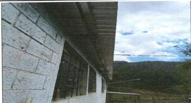
Foto 2: Sustitución de canal de metal
