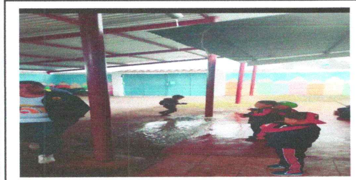
Foto 5: Mejoramiento de bajadas de agua pluvial.
