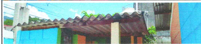
Foto1: Sustitución de lámina por lámina troquelada calibre 26
