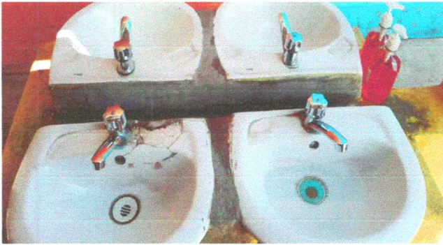
Foto7: Sustitución de lavamanos
