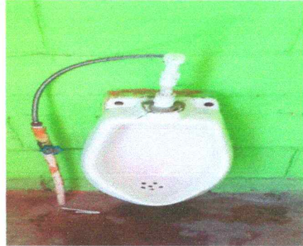
Foto 8 Sustitución de Mingitorio
