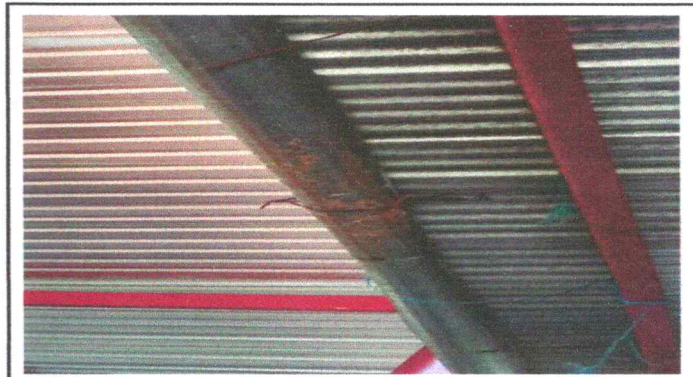
Foto 4: Sustitución de canal de PVC
