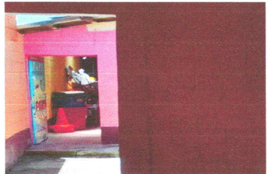
Foto 10. Mejoramiento de puerta de metal de aula
