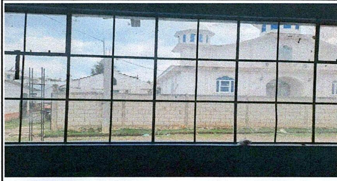
Foto 3: sustitución de vidrios
