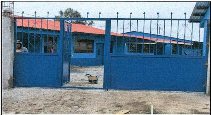
Foto 2: sustitución de porton de madera a porton de metal
