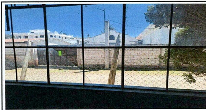
Foto 3: sustitución de vidrios
