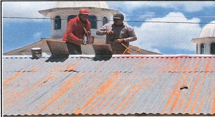
Foto 1: Protección de lamina con pintura anticorrosiva.
