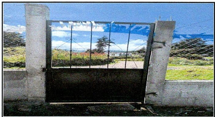
SUSTITUCION DE PUERTA DE MADERA POR PUERTA DE METAL
