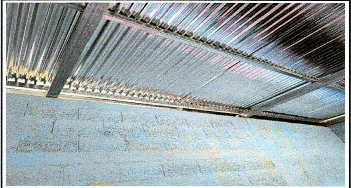
SUSTITUCION DE ESTRUCTURA DE SOPORTE DE TECHO DE MADERA POR METAL
