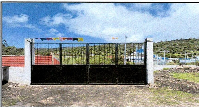
SUSTITUCION DE PORTON DE LAMINA POR PORTON DE METAL
