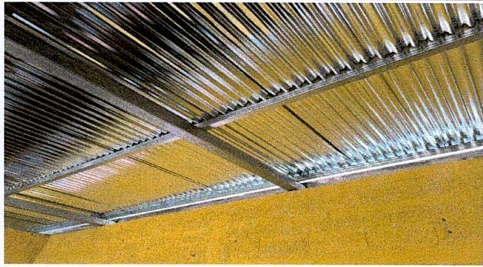
SUSTITUCION DE LAMINA POR LAMINA
