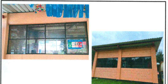
Foto 6: Mejoramiento de balcones para ventana
