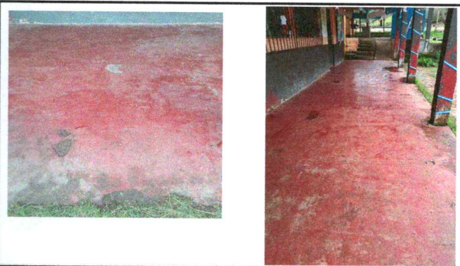
Foto 4: Sustitución de piso de torta de concreto
