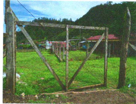
Foto 8: Sustrucción de portón de metal de 2 metros por 3 metros
