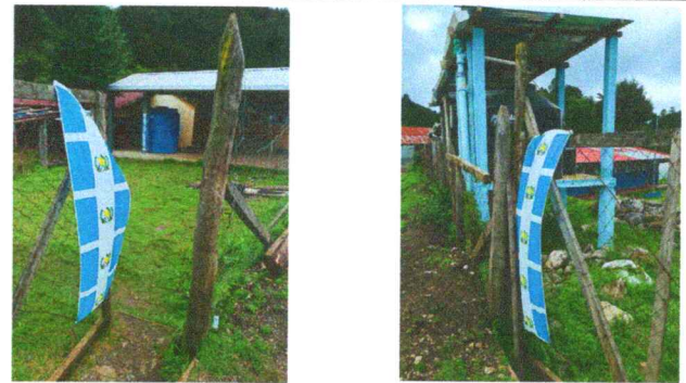
Foto 10: Sustrucción estructura de soporte para portón
