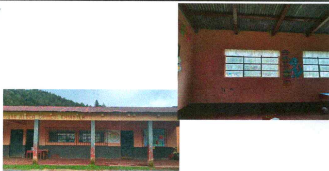
Foto 5: Pintura de exteriores e interiores
