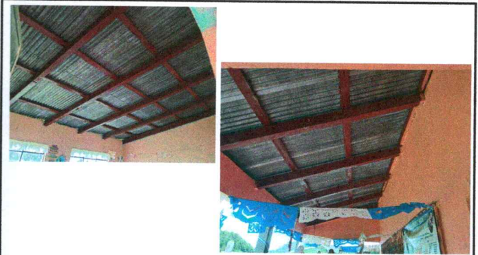
Foto 2: Sustitución de soporte de estructura de madera por metal
