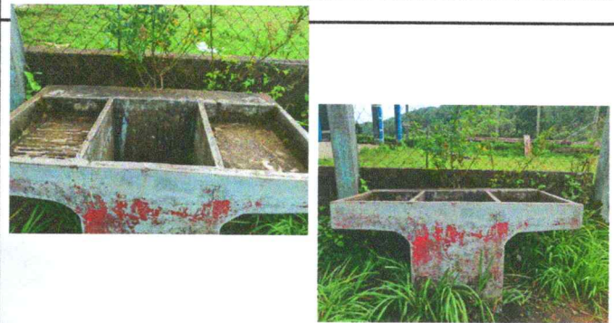
Foto 12: Sustrucción de Pila de dos lavaderos
