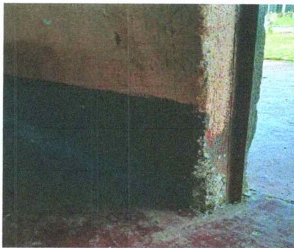
Foto 9: Repello en muro
