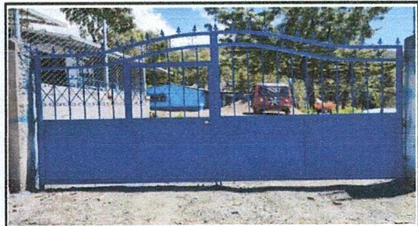
Foto 2: Puerta de Metal
