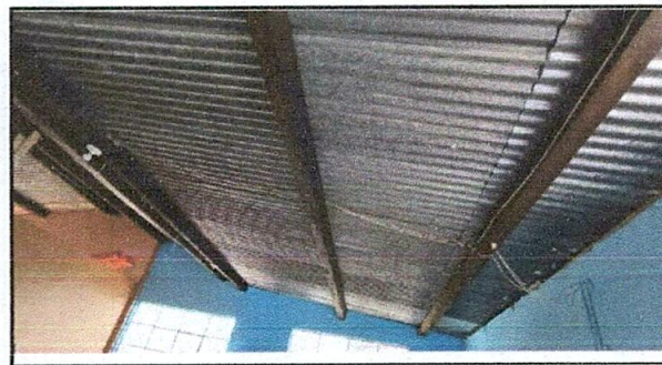
Foto 6: Reparación del sistema eléctrico
