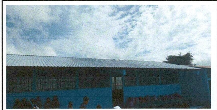
Foto 1: Sustitucion de lamina por lamina
