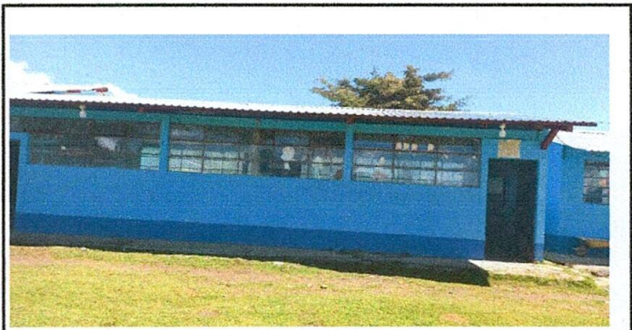
Foto 4: Sustitución de estructura de techo y lamina
