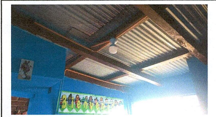
Foto 1: Sustitución de flapones
