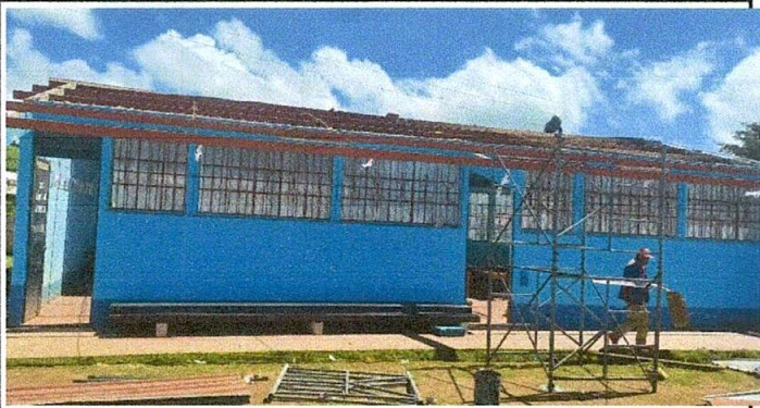
Foto 1: Sustrucion de lamina por lamina
