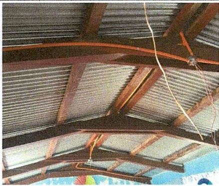
Foto 3: Sustrucion de cableado electrico
