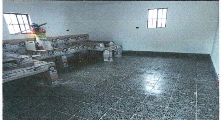
Foto 2: Sustitución de Piso en Cocina
