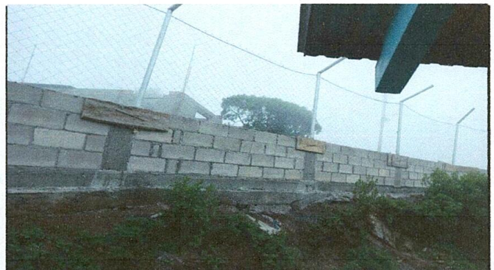
Foto 4: Sustitución de cerco de madera por Block y tubo galvanizado
