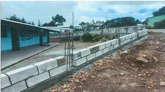
Foto 3: Sustitución de cerco de madera por Block y tubo galvanizado
