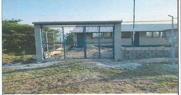
Foto 2: Cerco o Muro Perimetral
