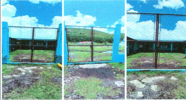
Foto1: SUSTITUCIÓN DE PORTÓN DE METAL
