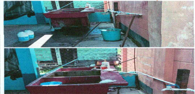
Foto 6: REPARACIÓN DE LAVAMANOS MULTIFUNCIONAL DE CONCRETO Y AZULEJO
