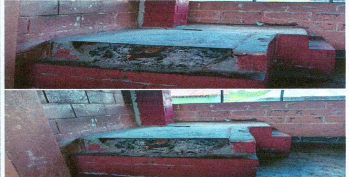
Foto 10: MANTENIMIENTO A ESTUFA RURAL E INSTALACIÓN DE AZULEJO EN ESTUFA RURAL
