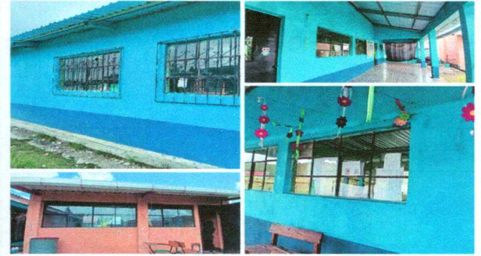
Foto 2: MEJORAMIENTO DE BALCONES A METAL
