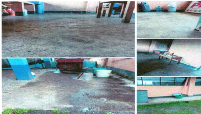
Foto 3: SUSTITUCIÓN DE PISO DE TORTA DE CONCRETO POR GRANITO
