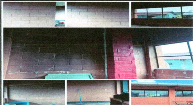
Foto 4: PINTURA EN MUROS EXTERNOS E INTERNOS
