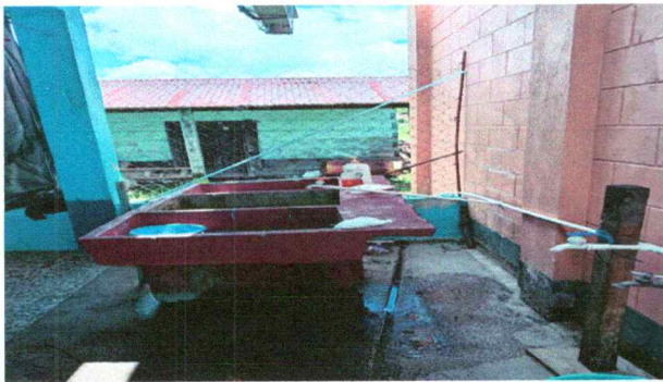
Foto 9: SUSTITUCIÓN DE DEPOSITO DE AGUA 2,500 LTS
